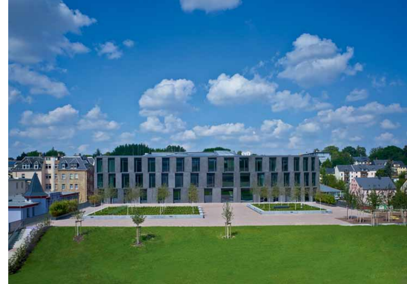
Südfassade des ZMS mit Außenanlagen
